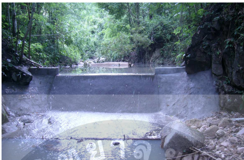
รูปที่ 5 ฝายชะลอน้ำช่วยเก็บกักน้ำและชะลอการไหลของกระแสน้ำเพิ่มความชุ่มชื้น
