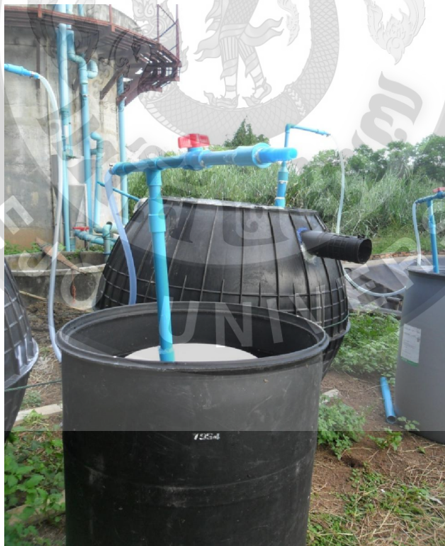
ภาพที่ 12 ระบบเก็บก๊าซชีวภาพโดยการแทนที่น้ำ
