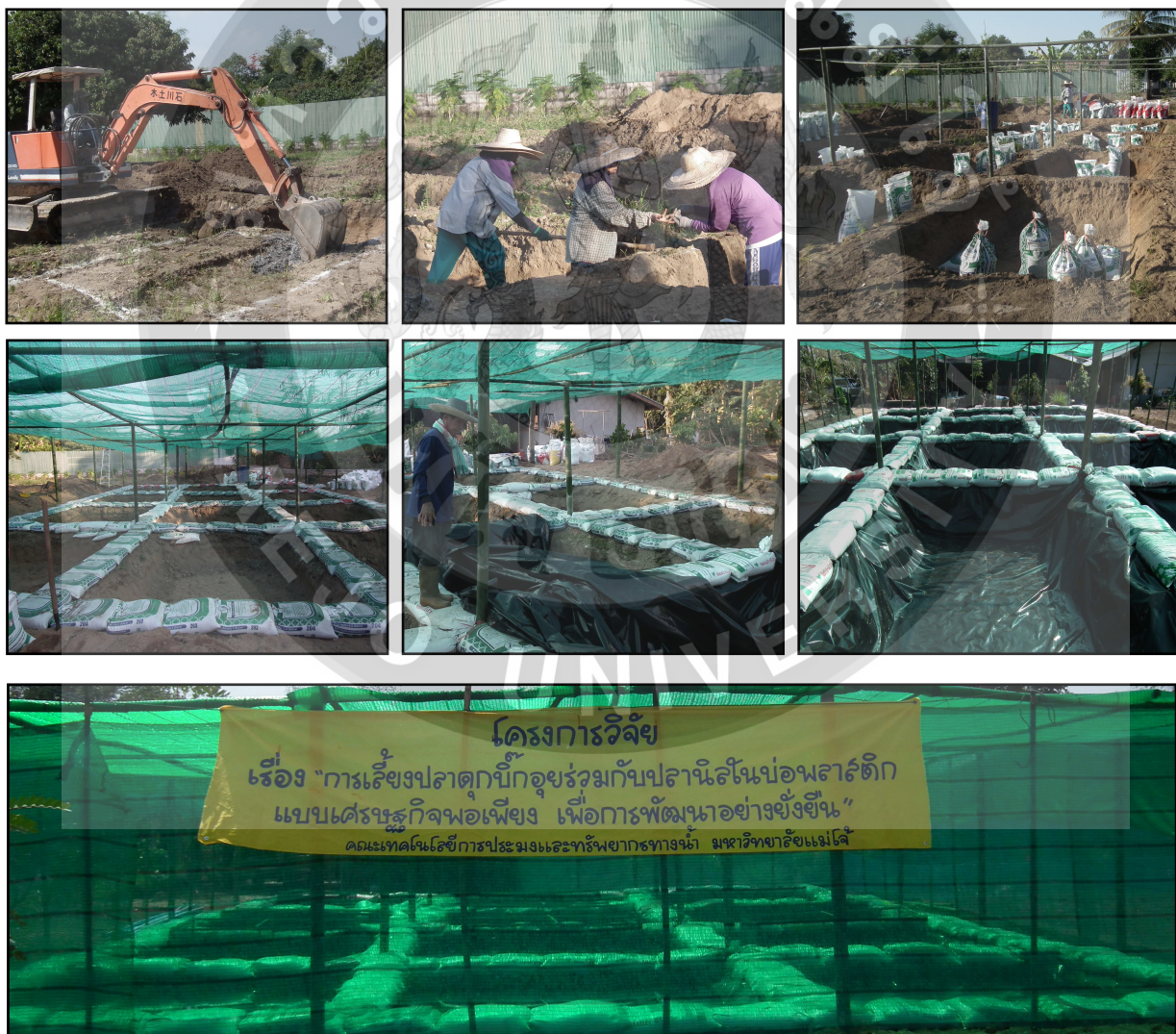
ภาพที่ 4 ขั้นตอนการขุดบ่อทดลองพร้อมปูพลาสติกสีดำที่พื้นบ่อในการทดลองที่ 1
