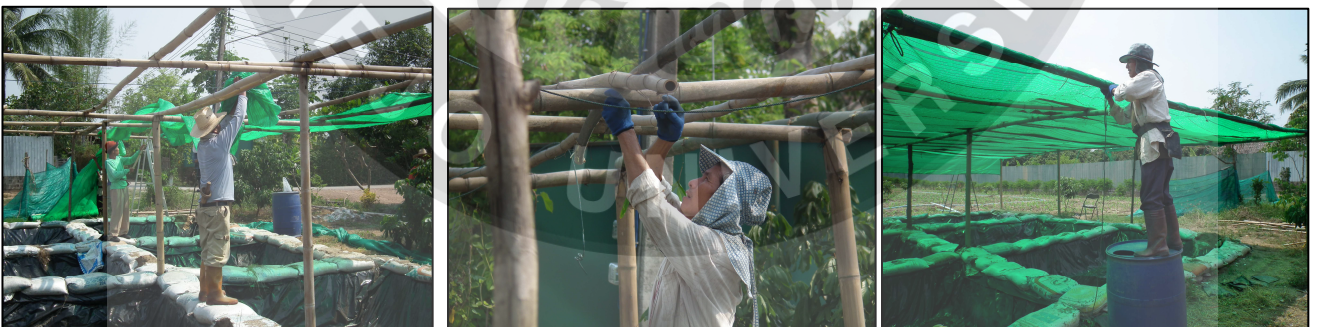
(จ) ซ่อมแซมและติดตั้งไม้ไผ่เพื่อทำเสาและคานหลังคา พร้อมติดตั้งหลังคาที่ทำด้วยตาข่ายพรางแสง 80%
