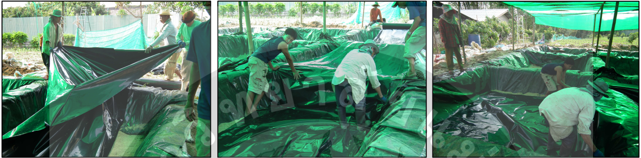
(ค) ทำการปรับปรุงซ่อมแซมพื้นบ่อ รองพื้นบ่อด้วยเกลบและทำการปูพลาสติกสีดำที่พื้นบ่อทดลอง
