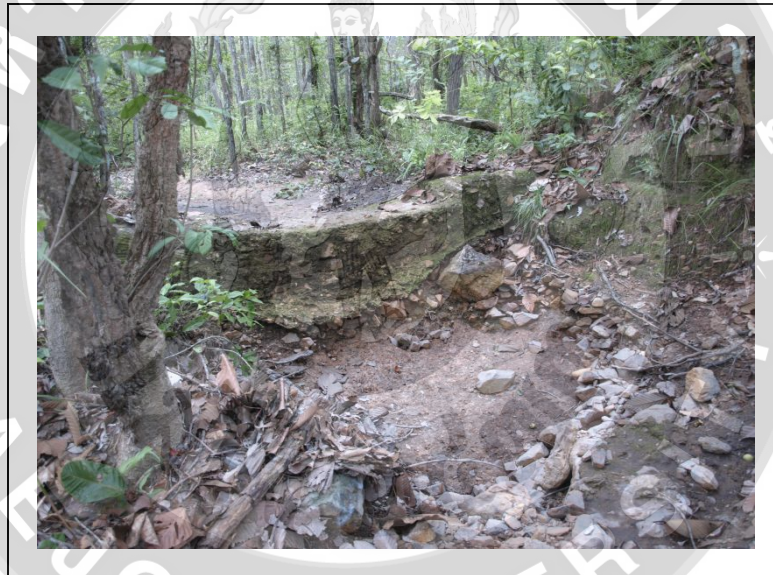
ภาพที่ 3.2 ฝายชะลอน้ำ คอนกรีตผสมหิน
