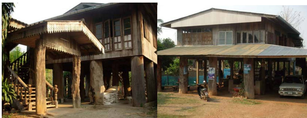
ภาพที่ 17 บ้านไม้ชั้นเดียวยกใต้ถุนสูงแบบเสาชขนาดใหญ่
