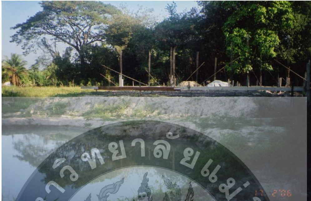
ภาพที่ 3.3 สถานีสกัดน้ำหอม 1 และ 2 จังหวัดเชียงใหม่ ขณะเริ่มวางฐานรากก่อสร้างอาคาร เมื่อวันที่ 17 กุมภาพันธ์ พ.ศ. 2549
