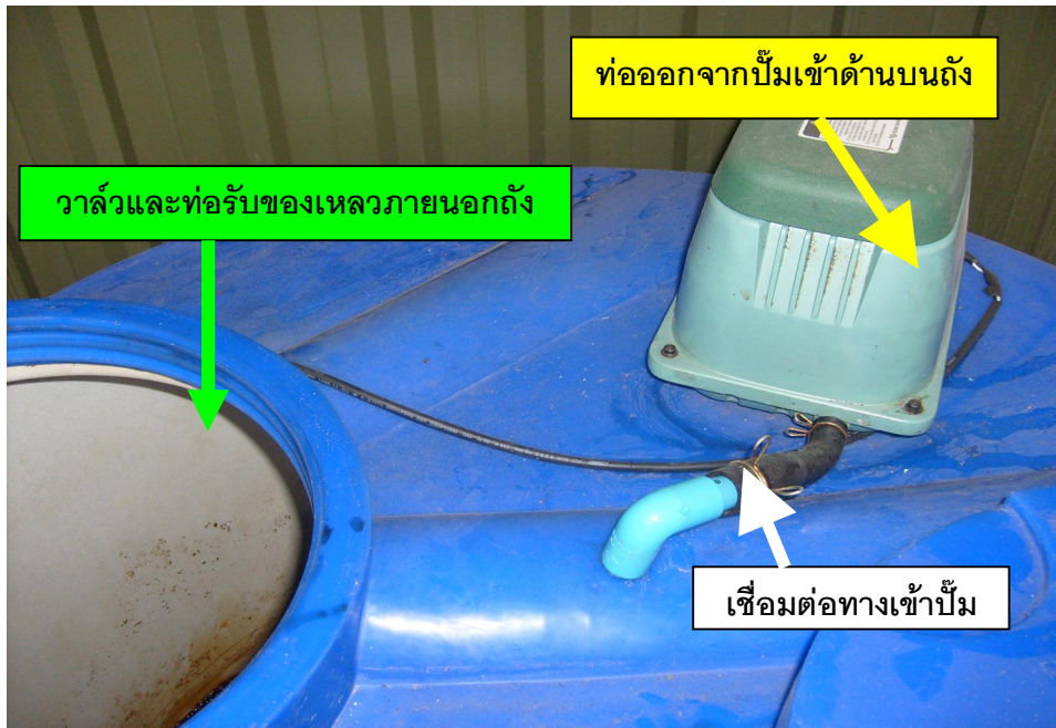
ภาพภาคผนวกที่ 12 การติดตั้งเครื่องผลิตออกซิเจนแบบมีตัวกรองกับถังหมักแบบเติมอากาศ
