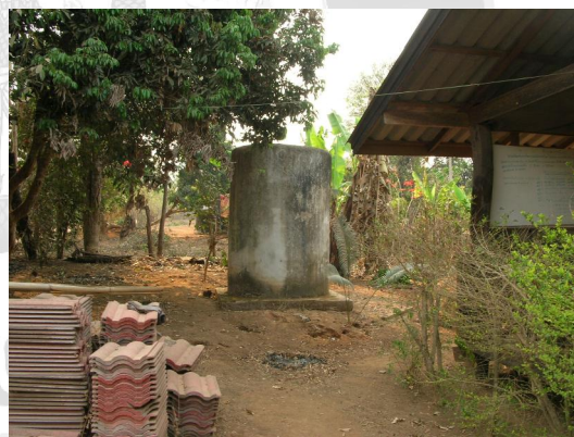
ภาพที่ 16 แท็งก์เก็บน้ำ ระบบประปาภูเขา
