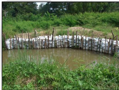
ภาพ 18-19 ลักษณะการซ่อมแซมตลิ่งสองฝั่งน้ำ
