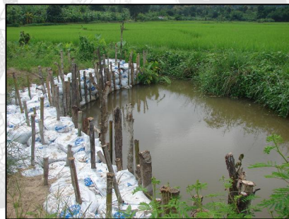
ภาพ 18-19 ลักษณะการซ่อมแซมตลิ่งสองฝั่งน้ำ
