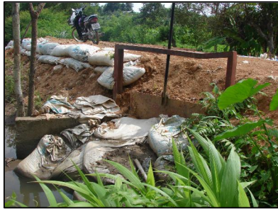
ภาพ 11-12 ประตูเปิด-ปิดน้ำ, ลำเหมืองไส้ไก่
