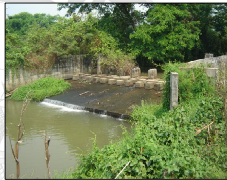
ภาพ 5 ลักษณะฝายที่เปลี่ยนเป็นคอนกรีต
