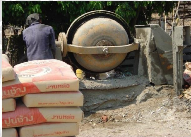
ภาพ 4.15 การผสมปูนท่ามกลางแสงแดดอันแรงจ้าในยามบ่ายของภาคฤดูร้อน
