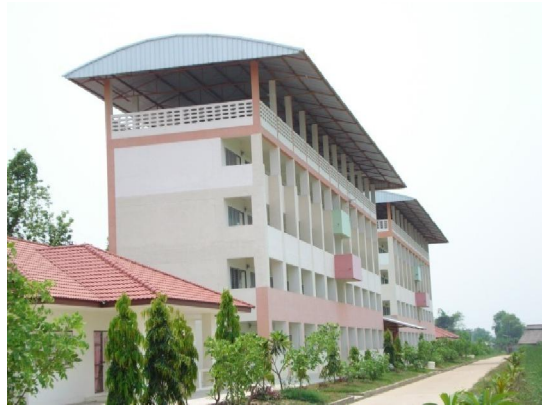
ภาพ 4.65 สวัสดิการหอพัก จำนวน 2 อาคาร 4 ชั้น และชั้นดาดฟ้า ที่นายจ้างจัดให้แก่แรงงาน พม่า ส่วนบ้านชั้นเดียวเป็นบ้านพักระดับชั้นปฏิบัติการของลูกจ้างคนไทย
