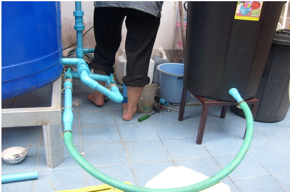
ภาพภาคผนวกที่ 13 การต่อท่อจากช่องทางรับของเหลวภายนอกกับถังผสม
