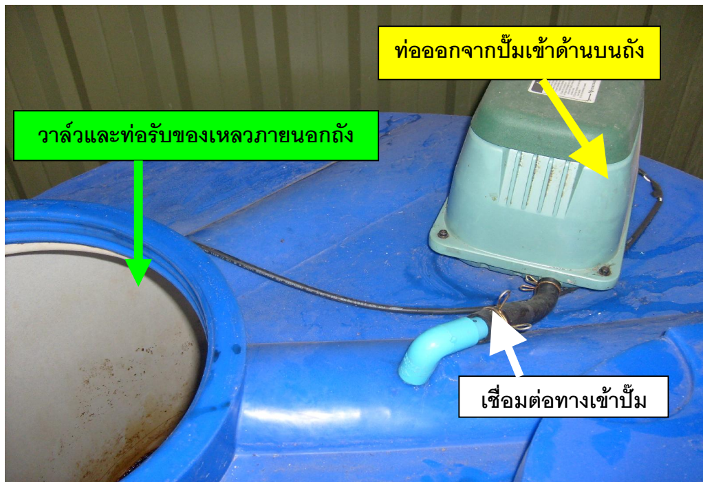
ภาพภาคผนวกที่ 12 การติดตั้งเครื่องผลิตออกซิเจนแบบมีตัวกรองกับถังหมักแบบเติมอากาศ
